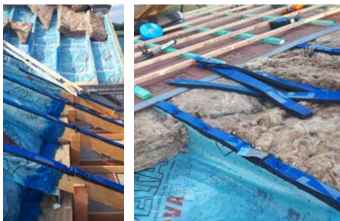
Obrázok 8, 9: Doteplenie krokiev pomocou prírezov fólie DELTA®-MAXX COMFORT a aplikácia poistnej hydroizolácie DELTA®-FOXX PLUS
