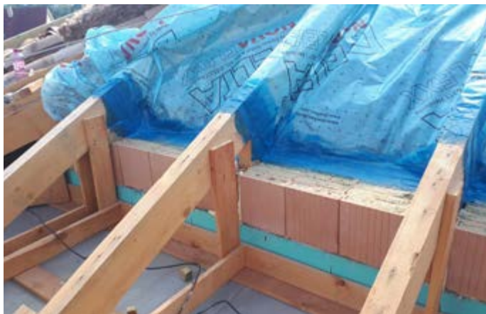
Obrázok 6: Napojenie parobrzdzy DELTA®-NOVAFLEX na obvodové murivo prostredníctvom DELTA®-LIQUIXX
