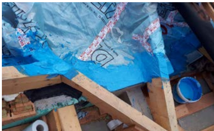
Obrázok 7: Napojenie parobrzdzy DELTA®-NOVAFLEX na obvodové murivo – aj v komplikovaných detailoch prostredníctvom DELTA®-LIQUIXX
