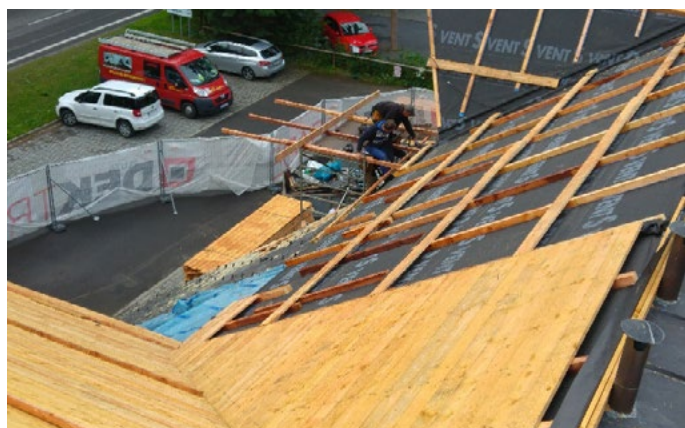
Obr. č. 7 Pohľad na realizáciu tesárskych konštrukcií
