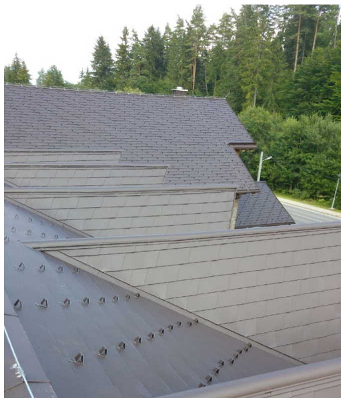
Obr. č. 9 Pohľad na hotovú strešnú krytinu PREFA strešný šindel, farba P.10 oreškovohnedá
