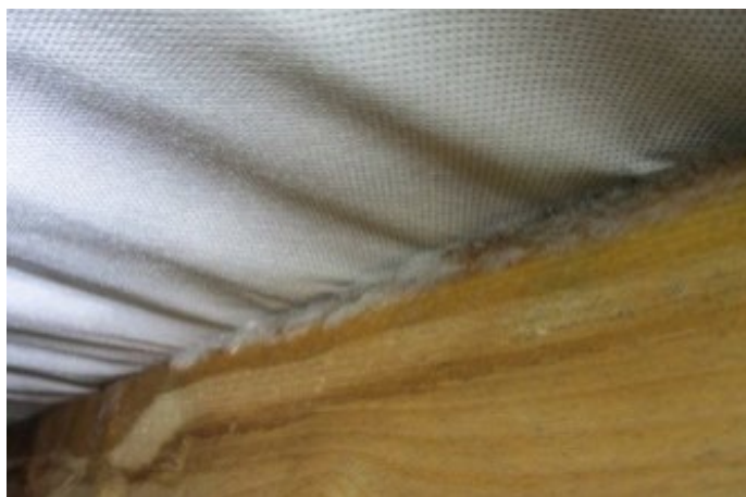
Prekročenie hranice rozmerovej stálosti, alebo tzv. "prepnutie" fólie
