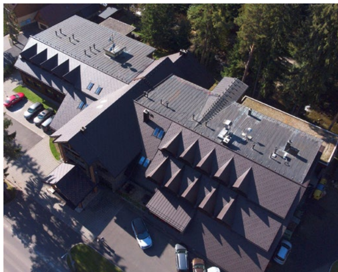
Obr. č. 10 Celkový pohľad na hotovú strešnú krytinu PREFA strešný šindel na Hoteli Tri Studničky v Demänovskej doline
